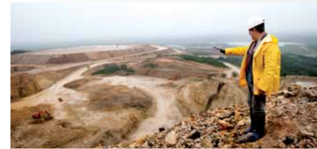
Управление взрывными работами на Хакандже
