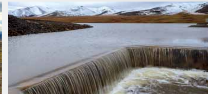
Хвостохранилище на Майском
