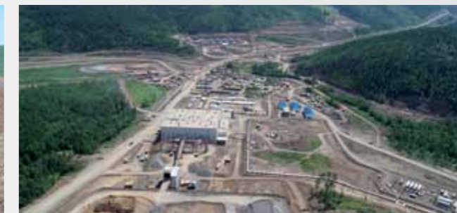
Фабрика на месторождении Албазино
