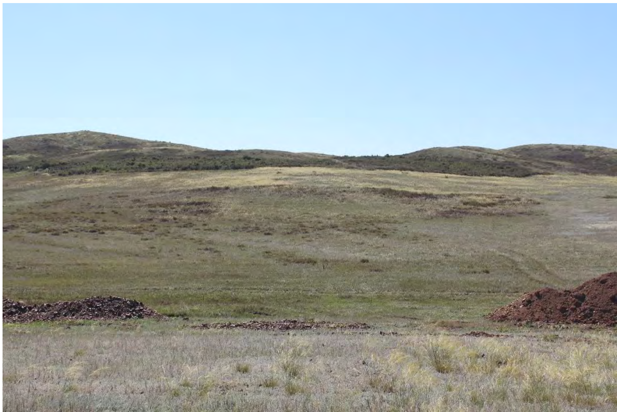
Рис. 4.17: Руслоотводной канал породного отвала (Фото №8)
