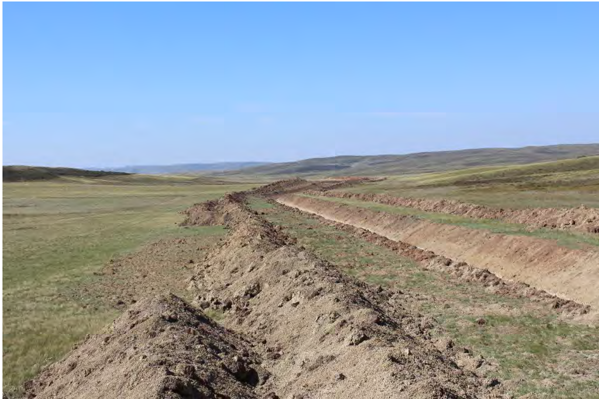
Рис. 4.14: Руслоотводной канал породного отвала (Фото №7)
