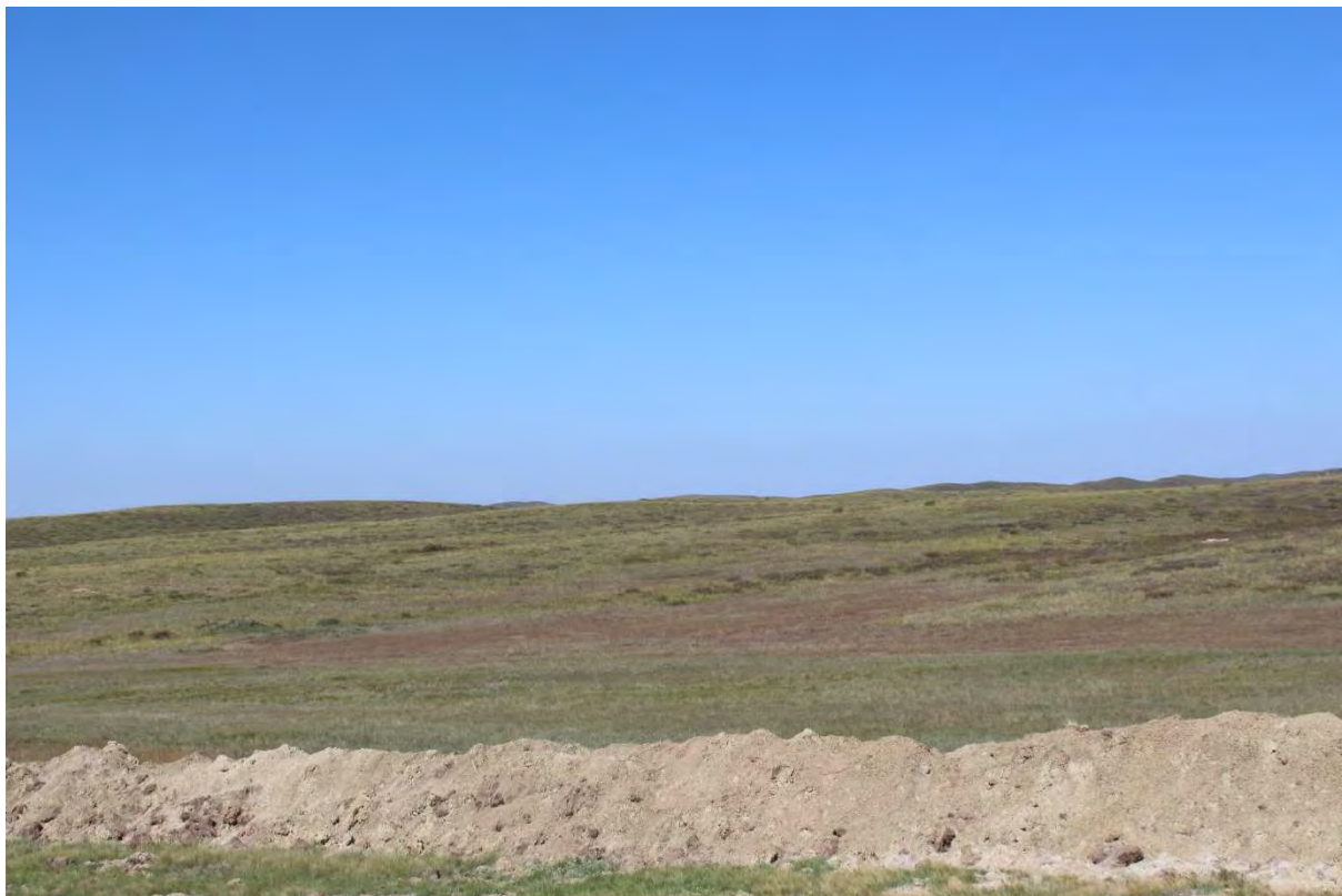
Рис. 4.15: Руслоотводной канал породного отвала (Фото №7)
